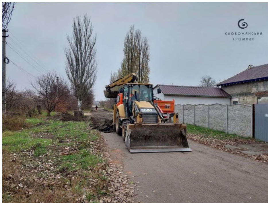
Під час ремонту по вул. Доновського.
